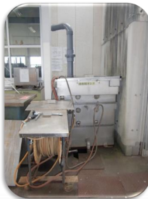
雨水タンク1号機
